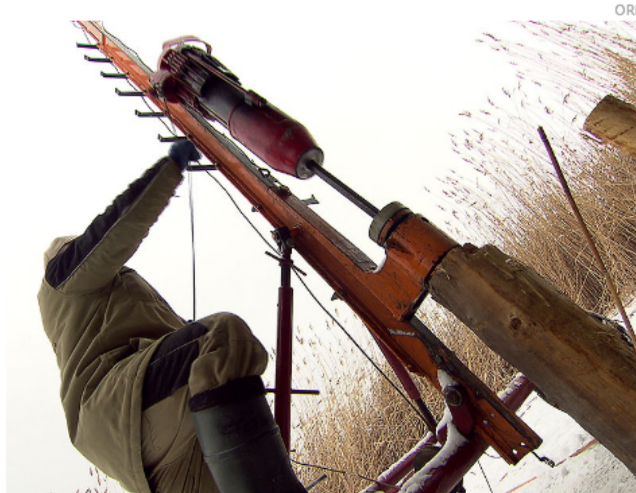
Manche Piloten müssen noch händisch eingeschlagen werden
